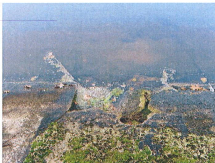
5 pav. Sulūžusios tvirtinimo plokštės
