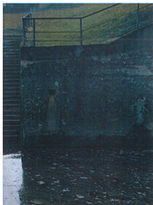
11 pav. Drenažo žiotys įrengtos SBGU galiniuose ramtuose
