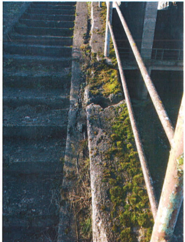
9 pav. Tarp ramto ir nulipimo laiptų susiformavę plyšiai
