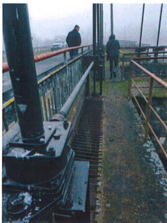
15 pav. Uždorių valdymo įranga tvarkinga, nudažyta, judančios detalės suteptos, tačiau pagrindinių uždorių valdymo mechanizmų dalis sriegių nežymiai paveikta korozijos
