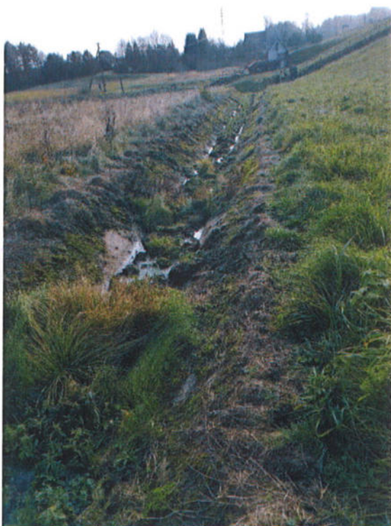
22 pav. Kairėje pusėje latakas nevalytas, užneštas nešmenimis ir žole (velėna); vanduo teka tiesiai ant risbermos plokščių
