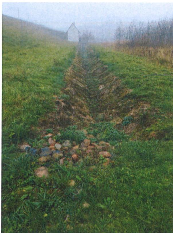
23 pav. Dešinėje pusėje latakas išvalytas, žiotys užneštos
