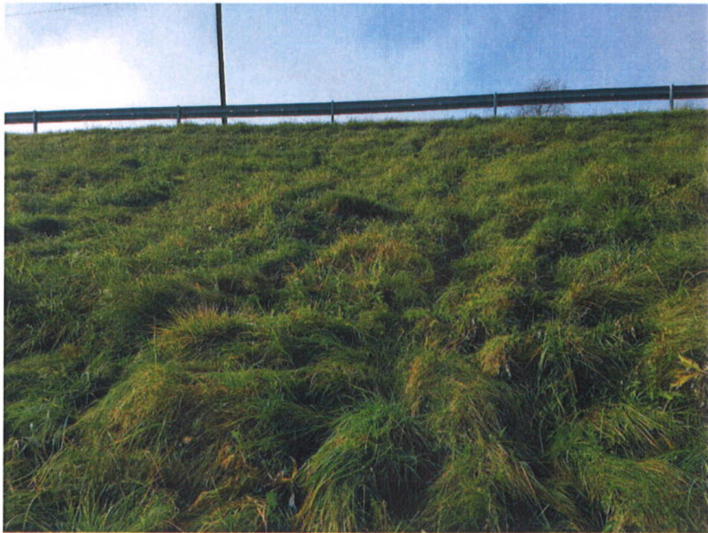
8 pav. Užmirkimo požymiai žemutiniame šlaite
