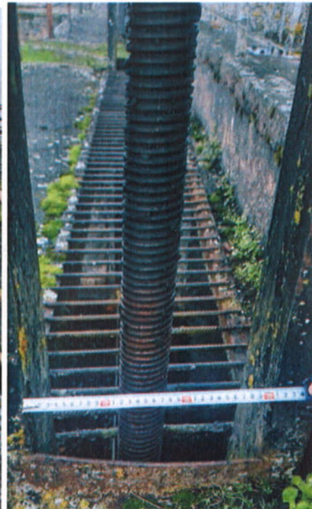
15 pav. Uždorių valdymo įranga tvarkinga, nudažyta, judančios detalės suteptos, tačiau pagrindinių uždorių valdymo mechanizmų dalis sriegių nežymiai paveikta korozijos
