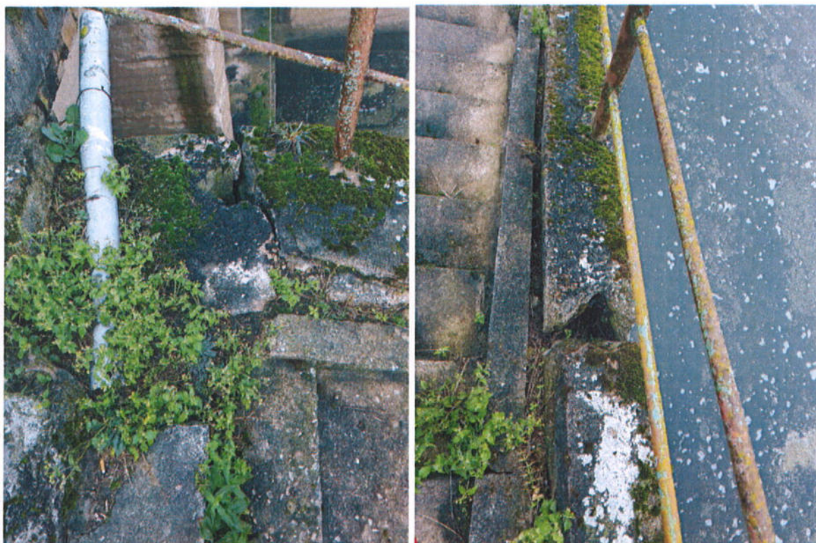
19 pav. Išsirusi deformacinė siūlė dešiniajame ir kairiajame ramtuose
