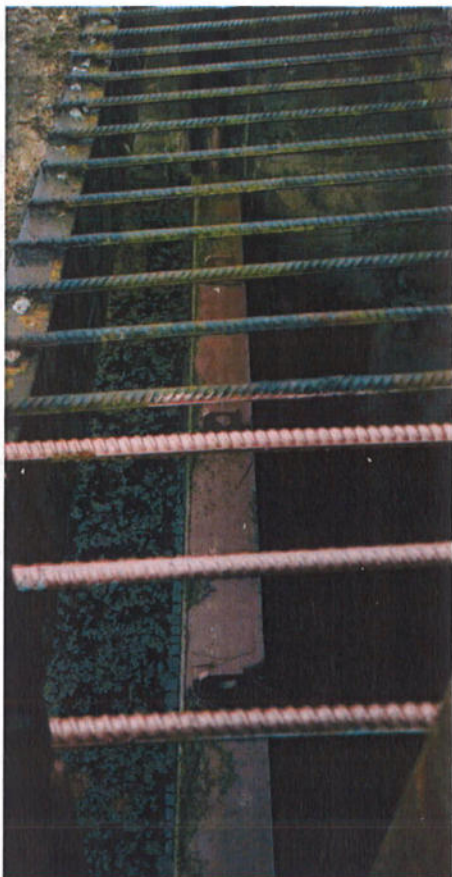
14 pav. Geros būklės pakeistas vidurinės angos uždoris ir nesandarus, nepakankamo standumo dešinysis uždoris, kurį būtina keisti
