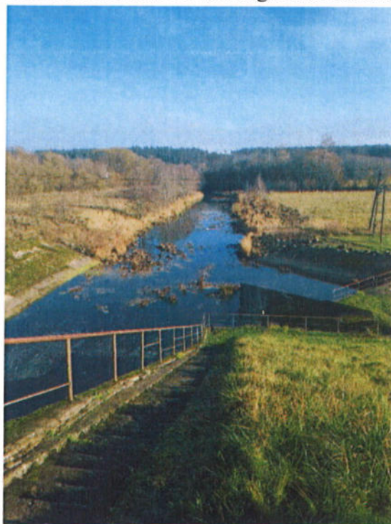
28 pav. Nutekėjimo kanalo krantuose auga pavieniai medžiai ir krūmai, vaga prižėlusi vandens augmenijos
