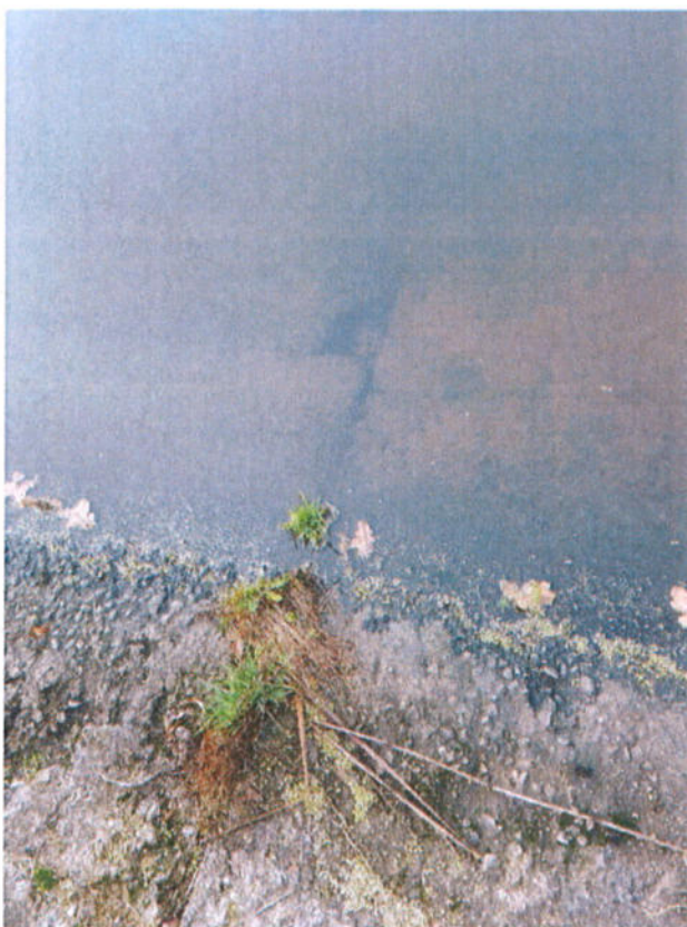
6 pav. Išplautos sujungimo siūlės (kairėje); prie vandens paimos iškilnotos plokštės (dešinėje)
