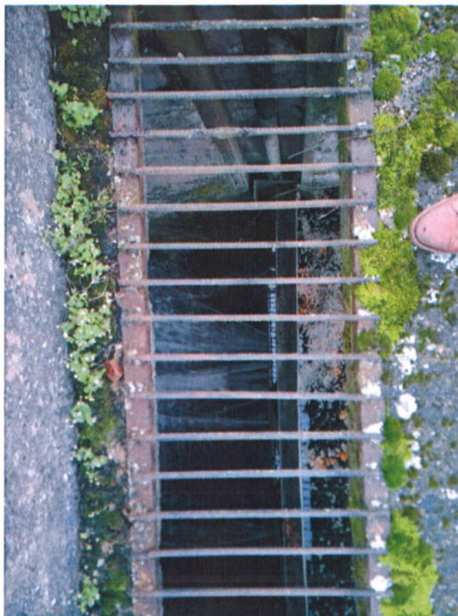
14 pav. Geros būklės pakeistas vidurinės angos uždoris ir nesandarus, nepakankamo standumo dešinysis uždoris, kurį būtina keisti
