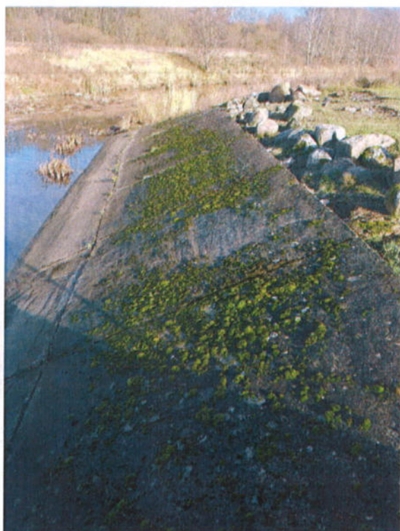
25 pav. Risbermos plokščių paviršius paveiktas biokorozijos – apaugęs samanomis
