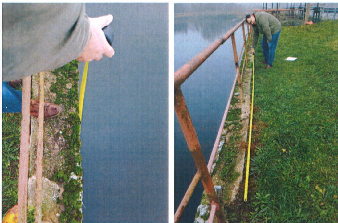
13 pav. Kairėje pusėje priekinis ramentas pasviręs į tvenkinio pusę
