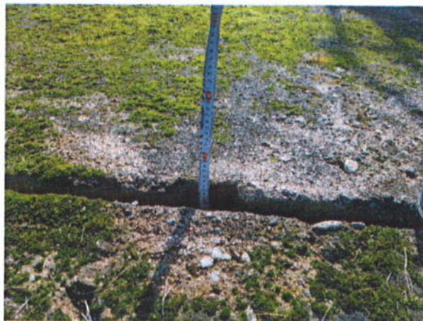
26 pav. Risbermos dešiniajame šlaite sulūžusios plokštės (kairėje); tarpai tarp plokščių (dešinėje)
