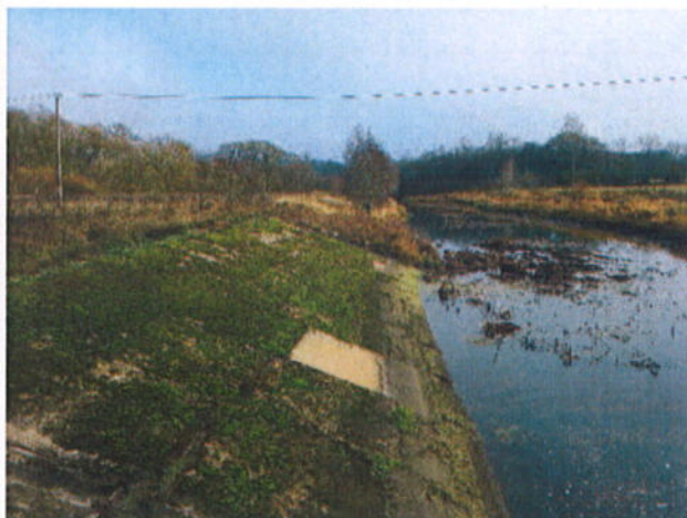
25 pav. Risbermos plokščių paviršius paveiktas biokorozijos – apaugęs samanomis
