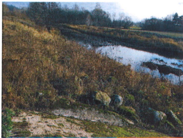
27 pav. Galinis tvirtinimas netvarkingai sumestais akmenimis
