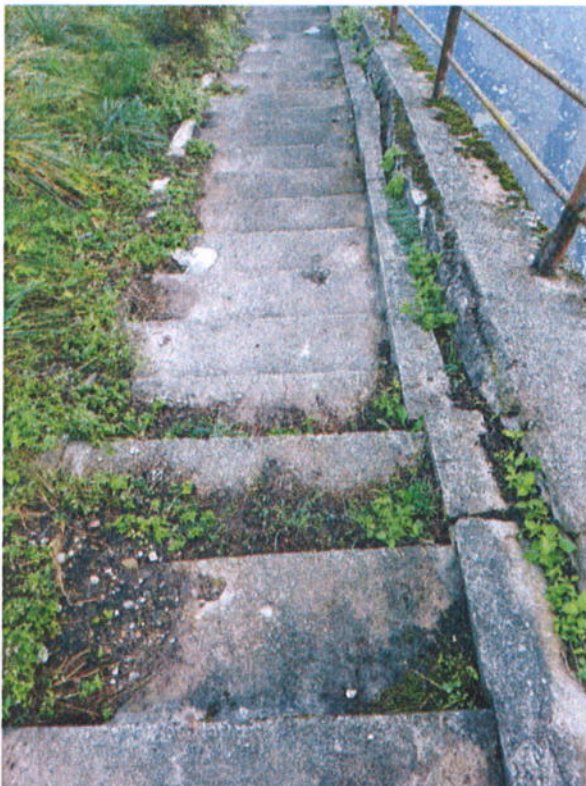
9 pav. Tarp ramto ir nulipimo laiptų susiformavę plyšiai
