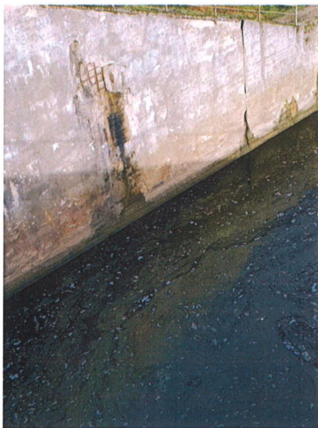
18 pav. Kairiajame ramte didelis plotas nutrupėjusio betono, matyti armatūra
