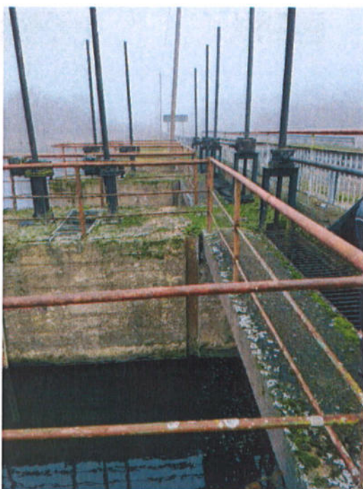
24 pav. Tarnybiniai tilteliai. Slenksčio, taurų ir tilto perdangos apžiūrai skirtas tarnybinis tiltelio plokštės pažeistos korozijos – plokštės briaunose matosi plika, korozijos paveikta armatūra
