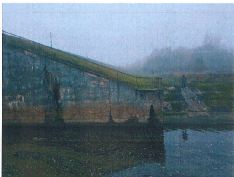
11 pav. Drenažo žiotys įrengtos SBGU galiniuose ramtuose
