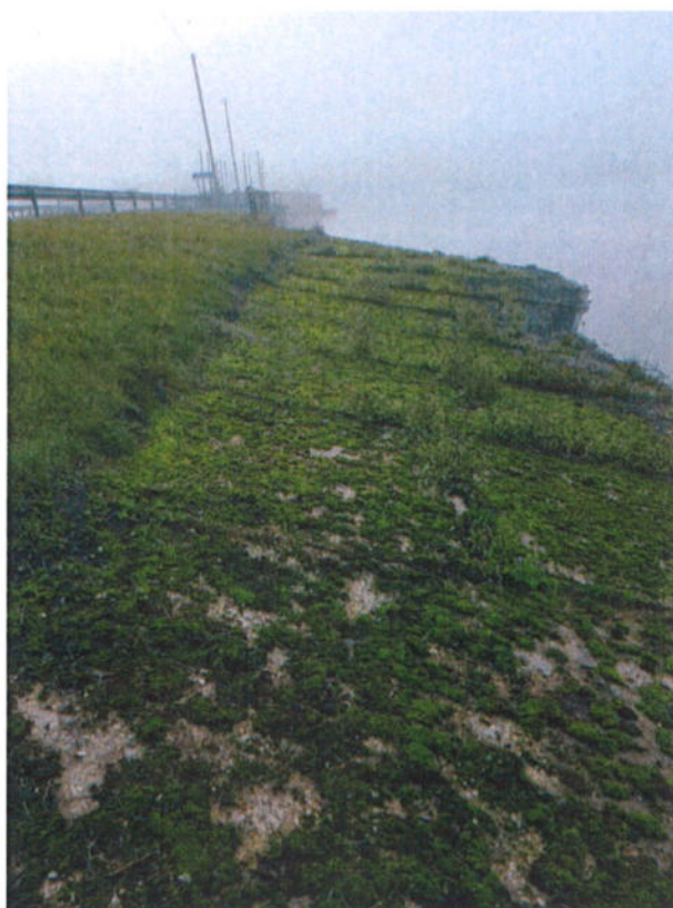
4 pav. Aukštutinio šlaito tvirtinimo plokščių paviršius stipriai paveiktas biokorozijos – auga samanos, tarpuose auga žolės
