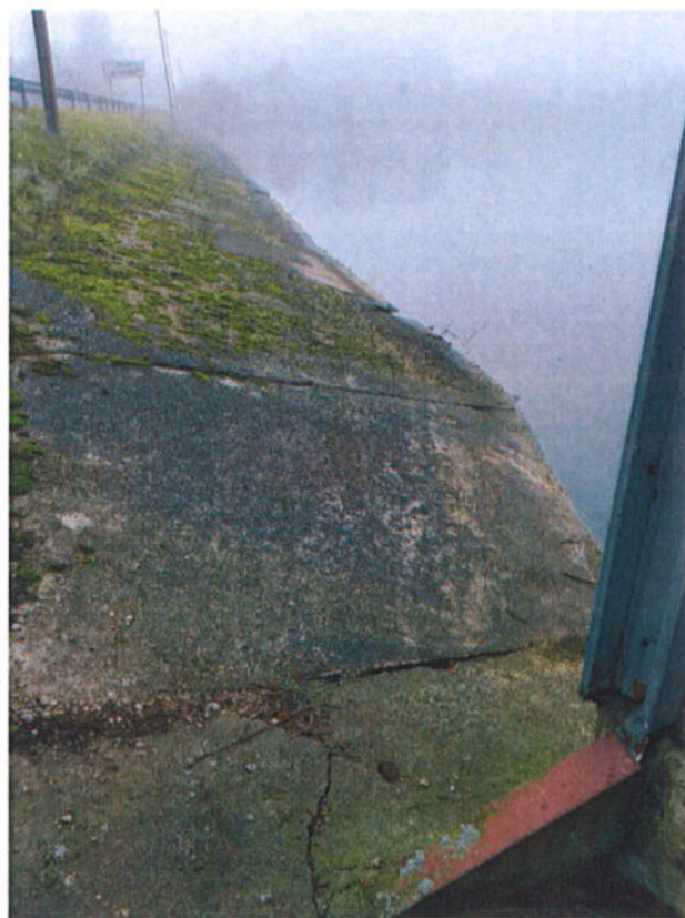
6 pav. Išplautos sujungimo siūlės (kairėje); prie vandens paimos iškilnotos plokštės (dešinėje)
