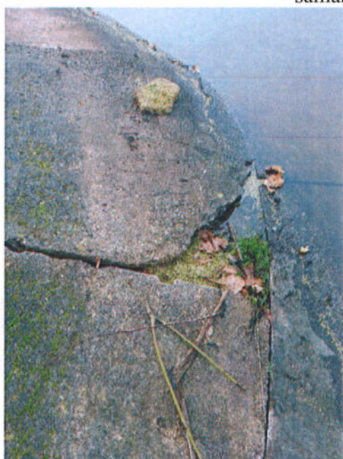
4 pav. Aukštutinio šlaito tvirtinimo plokščių paviršius stipriai paveiktas biokorozijos – auga samanos, tarpuose auga žolės
