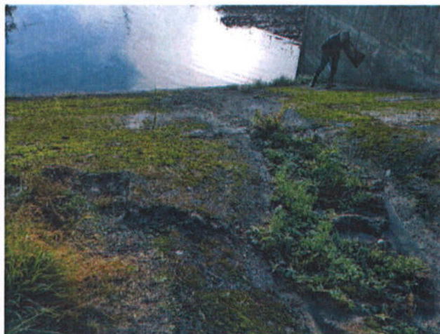
22 pav. Kairėje pusėje latakas nevalytas, užneštas nešmenimis ir žole (velėna); vanduo teka tiesiai ant risbermos plokščių
