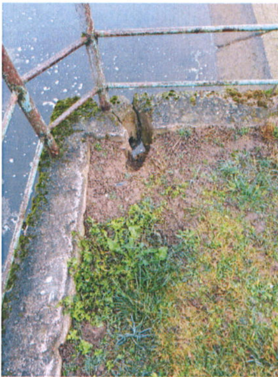
20 pav. Dešiniojo galinio ramto viršus suskilęs ir ištrupėjęs betonas, matyti kiauriniai plyšiai, išgraužos ties matuokle
