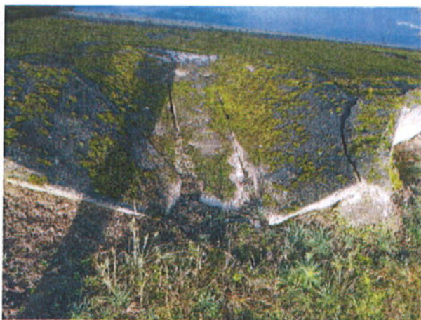
26 pav. Risbermos dešiniajame šlaite sulūžusios plokštės (kairėje); tarpai tarp plokščių (dešinėje)
