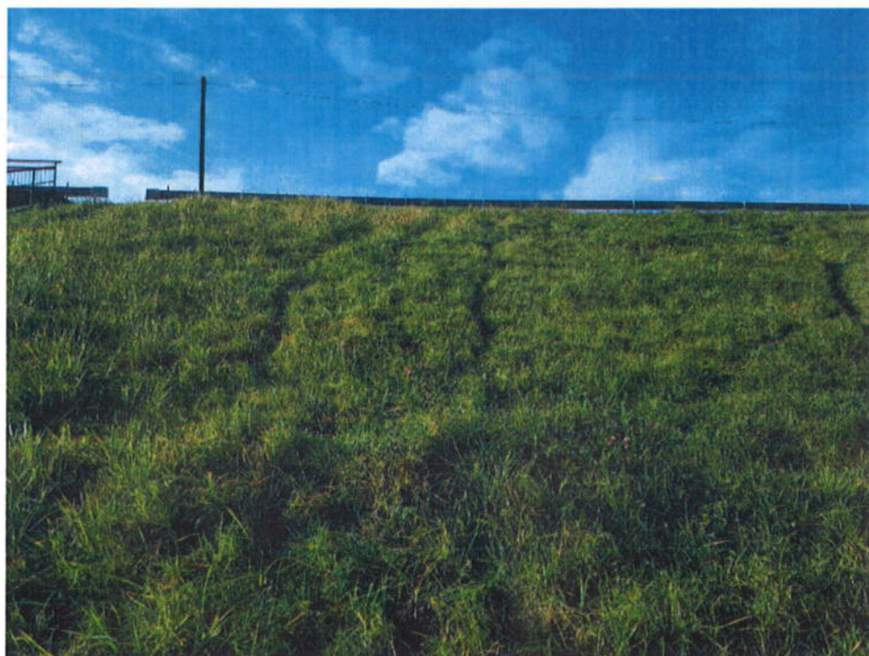
7 pav. Paviršinio vandens nutekėjimo žymės žemutiniame šlaite
